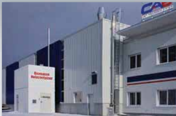
Container double pour le chauffage d'une entreprise.
