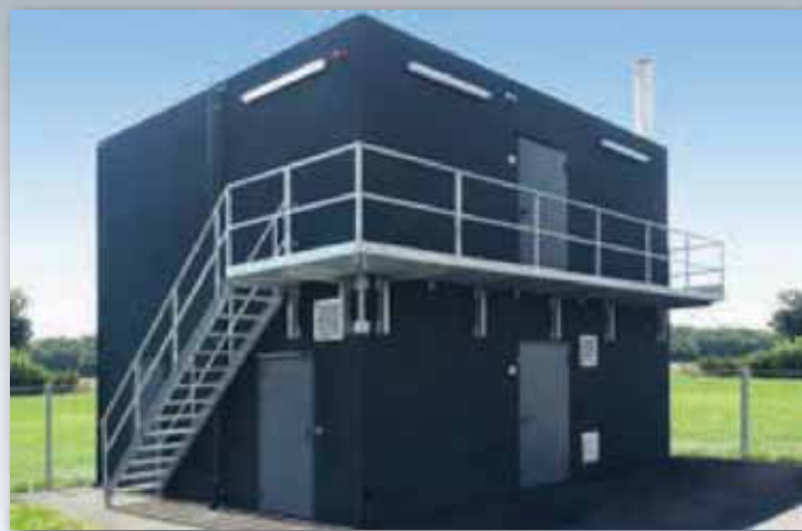
Container quadruple pour chauffer un bâtiment industriel.
